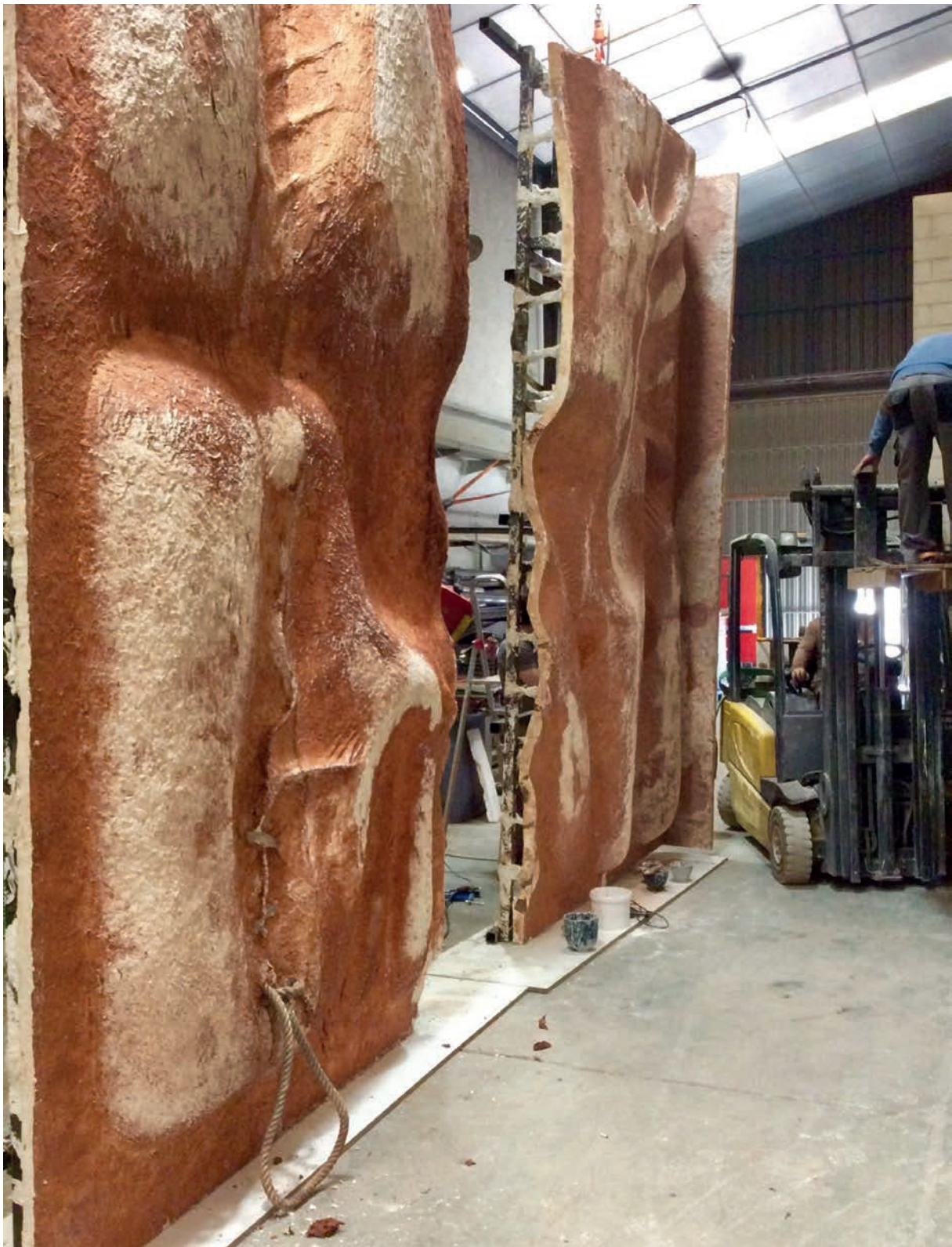
Moldes para hormigonar los murales de La Castellana
